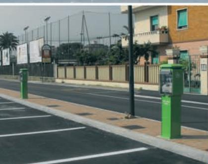
**Il sistema prepagato può funzionare con erogazione a tempo o a reale consumo elettrico.**
